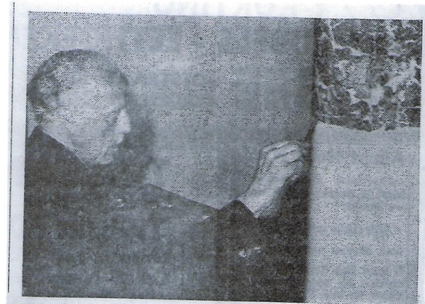
De heer Frans Hagnaars in volledige concentratie bij het marmere van de laatste kolom. „Je moet erop werken, dat het marmer wordt en niet langer verf is.”
